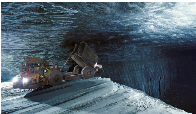
Unsere Versatzstoffe füllen Hohlräume optimal aus, so dass geomechanische Systeme langfristig gesichert sind.
